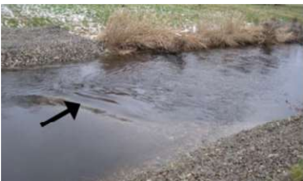
Abbildung 12: Kiesbuhne und Ufersicherung aus Grobkies und Geröll, mit flacher Schicht Feinkies oberstromseitig als Laichsubstrat (oben); Kiesdepot mit Ufersicherung auf beiden Seiten (unten); Fotos: L. Tent
