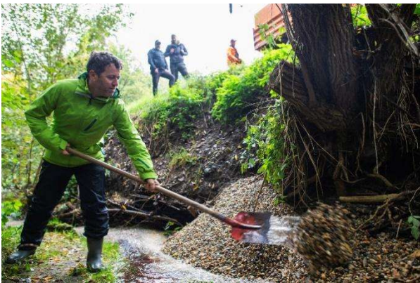
Abbildung 11: Kieseinbringung mit Bagger (oben) und mit Handschaufel (unten), © Peter Runkewitz
