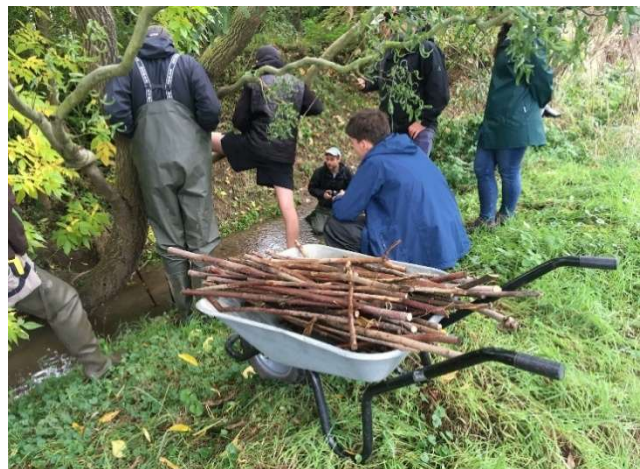
Abbildung 7: Versandeter Bachabschnitt (oben), Einbau von Haselnuss-Stöcken als Treibselsammler (unten) © Benjamin Gottfried
