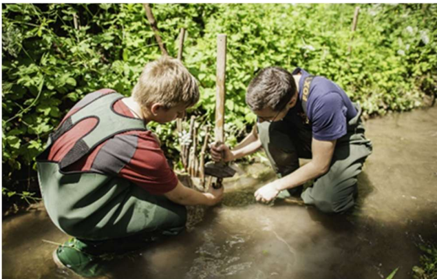
Abbildung 8: Installation der Stöcke mit dem Hammer bei niedrigem Wasserstand, Anordnung der Stöcke (zur Mitte des Bachs hin abfallend); Fotos: © Peter Runkewitz
